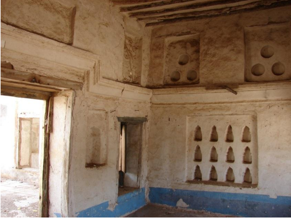
صورة رقم (12) الكوات الصغيرة والرف والفتحات الثلاث أعلى النوافذ. سمة مميزة لعمارة المخا. تصوير الباحث، 2010
