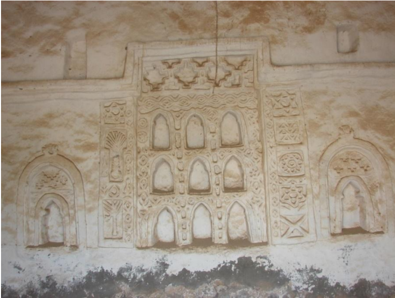
صورة رقم (11) مجموعة من الكوات في بيت المساوي تتوزع بشكل منتظم وحولها أشكال النخيل والنجمة السداسية والتي تظهر بكثرة في مختلف أرجاء تهامة ويعلوها رف بامتداد الغرفة. تصوير الباحث.
